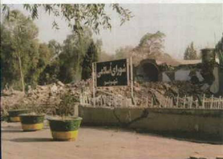
تصویر شماره ۳- نمای از ساختمان تخریب شده به‌مرامی و شورای شهر بم
