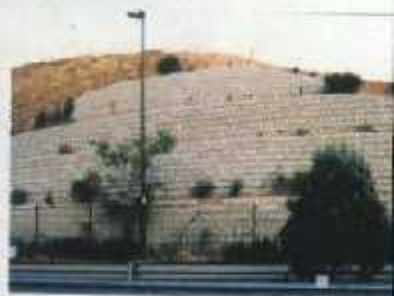
تهران - بزرگراه هست شرقی، ایجاد سازه‌های منسجم، پرهزینه منظر منظر و غیره برای حل اختلاف منظر در بزرگراهها
