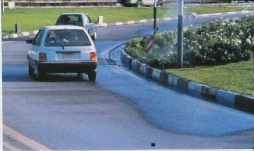
تهران - بزرگراه مدرس، استفاده از آبیاری برای آبیاری بدون پیش‌بینی تمهیدات لازم موجب بروز خطر و تقلیل عملکرد بزرگراه است.
